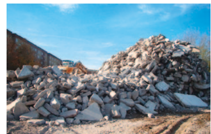
Abb. 4: Betonbruch im Ausgangszustand
