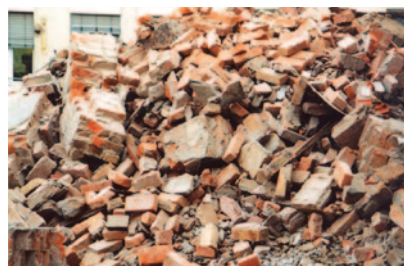
Abb. 3: Mauerwerkbruch im Ausgangszustand
