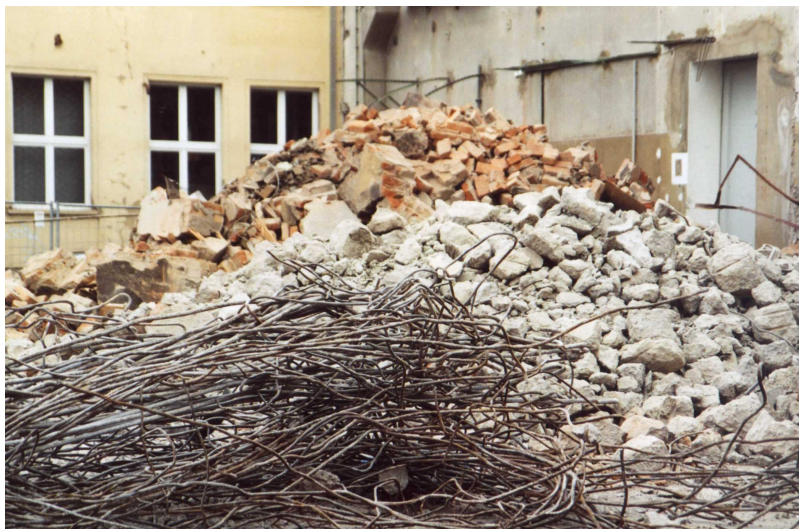
Bild 2- 2: Materialtrennung beim selektiven Abbruch (oben) und Beispiel für die mittels maschineller Vor-Ort-Sortierung getrennten Bestandteile (unten) [1]
