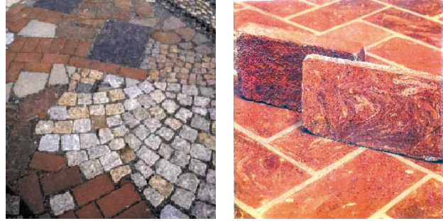
Bild 7: Recycling-Pflasterbelag mit gebrauchten Klinkern und Ziegeln (links) sowie Recycling-Fußbodenbelag aus geschnittenen und geschliffenen Handschlagziegeln (rechts) [35, 36] Fig. 7: Recycling pavement surface with used clinker pavers and bricks (left) and recycling floor covering from cut and ground hand-struck bricks (right) [35, 36]
