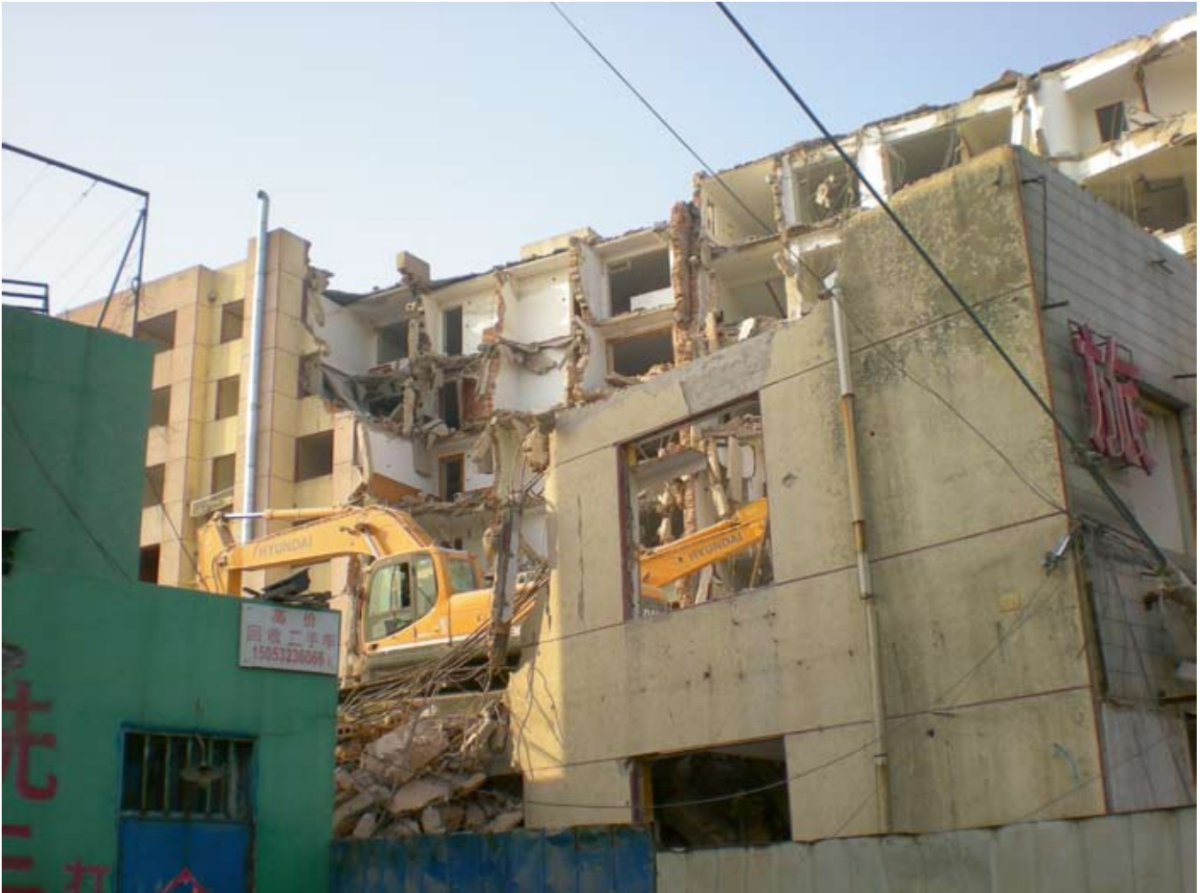
Abbruch von Wohngebäuden in China • Demolition of buildings in China
