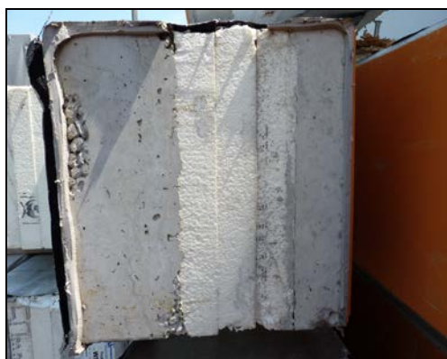
Abb. 5 und Abb. 6: Beispiele für integrierte Komponenten – Wärmedämmung in einem Betonfertigteile (links) und einem Hochlochziegel (rechts)
