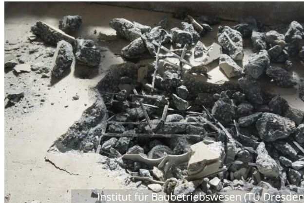
Freigelegte Bewehrungsstrukturen
