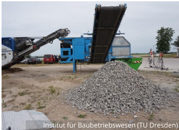
1. Durchgang „Brechen“ und „Windsichten“ mobile Anlage: Material auf 0/45 gebrochen
