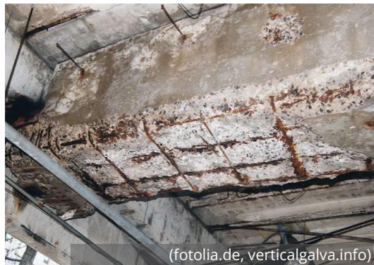
Korrosion der Stahlbewehrung
