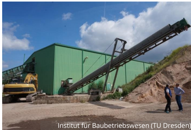
2. Durchgang „Brechen“ und „Windsichten“ stationäre Anlage: Material auf 0/16 gebrochen
