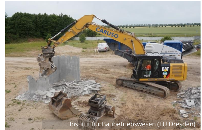
Totalabbruch beider Demonstratoren
