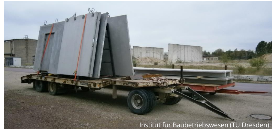
C 3 -Wände und -Decken kurz vor der Montage
