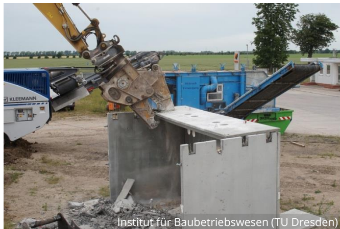
Abbruchverfahren „Pressschneiden“
