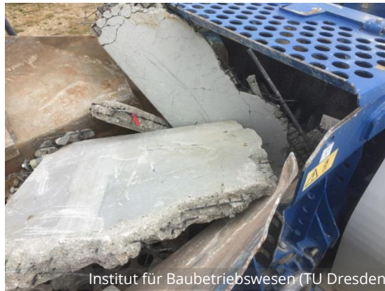
C 3 -Material im Backenbrecher
