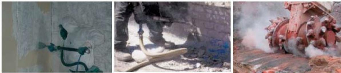
ABBILDUNG 3: VERSCHIEDENE MECHANISCHE VERFAHREN ZUR SCHADSTOFFABTRENNUNG<sup>67</sup>
